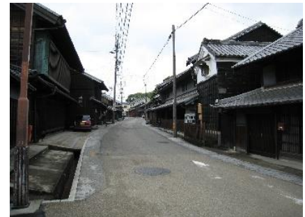
無電柱化前の様子(西町)
