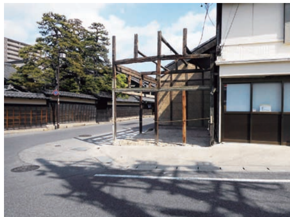
改築中の旧みどりカーテン
